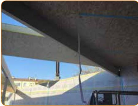
Mise en place des panneaux sandwichs sur les structures en bois.
