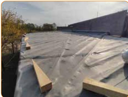
Les panneaux sandwichs sont bien sûr étanchés avant la pose des plaques de protection en acier Corten.
