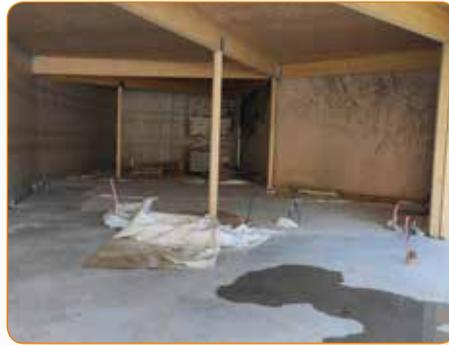
On voit ici les panneaux sandwichs en place ainsi que les tuyauteries et autres gaines en attente.
