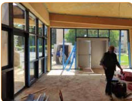
Les vitres, la porte principale et la porte latérale sont en place, le bâtiment est hors d'eau et hors d'air.
